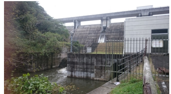
ダム堤体下流
