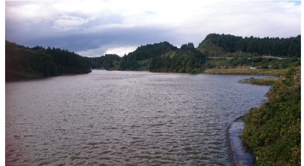
貯水位状況（堤体から上流を望む）
