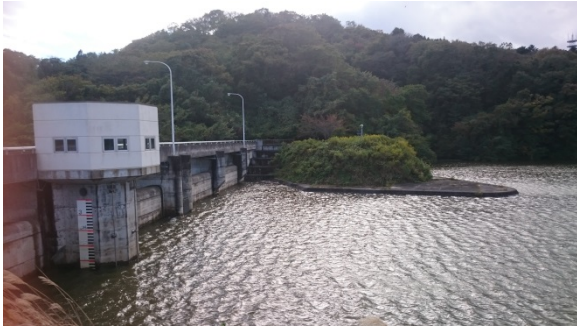
ダム堤体状況
