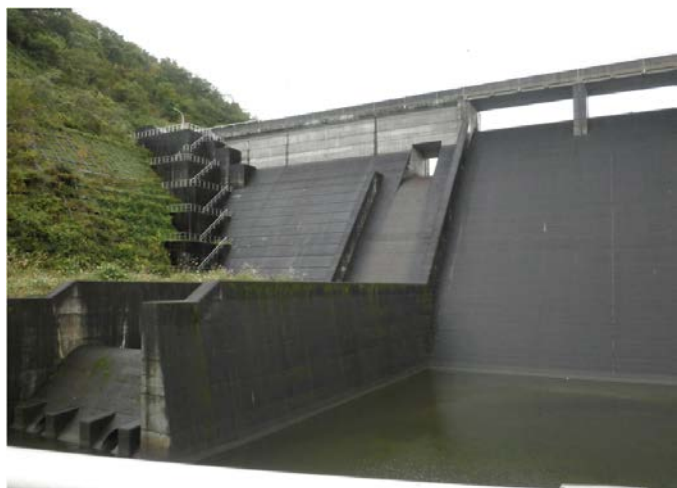
ダム本体付近
