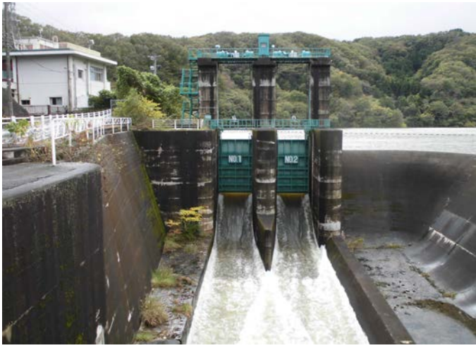
樽水ダム越流状況
