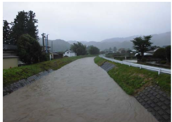
樽水ダム直下流部川上警報所下流部（上流を望む）
