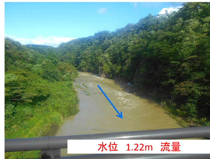
白沢水位観測所(洪水後 9月18日 8時03分)
