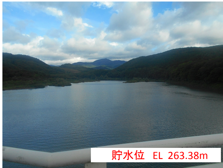
大倉大橋上流側(洪水後 9月18日 7時36分)
