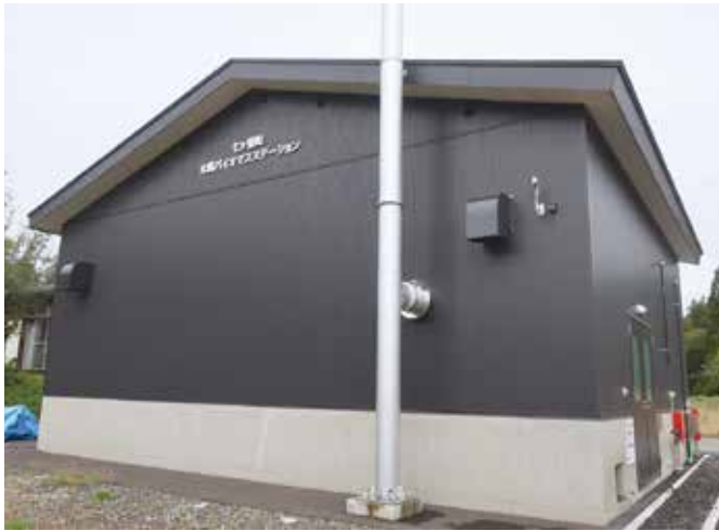
ボイラーやチップ貯蔵庫が入るバイオマスステーション
