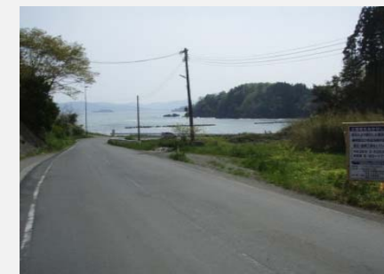
② 着手前 平成26年4月
