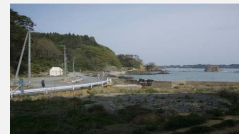
④ 着手前 平成26年4月
