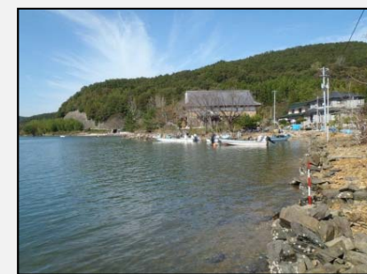
② 着手前 平成24年9月
