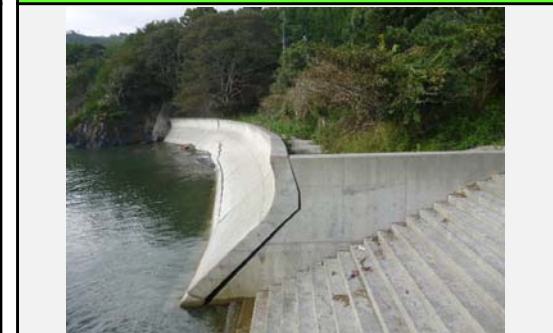
② 着手前 平成25年9月
