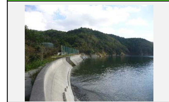
④ 着手前 平成25年9月
